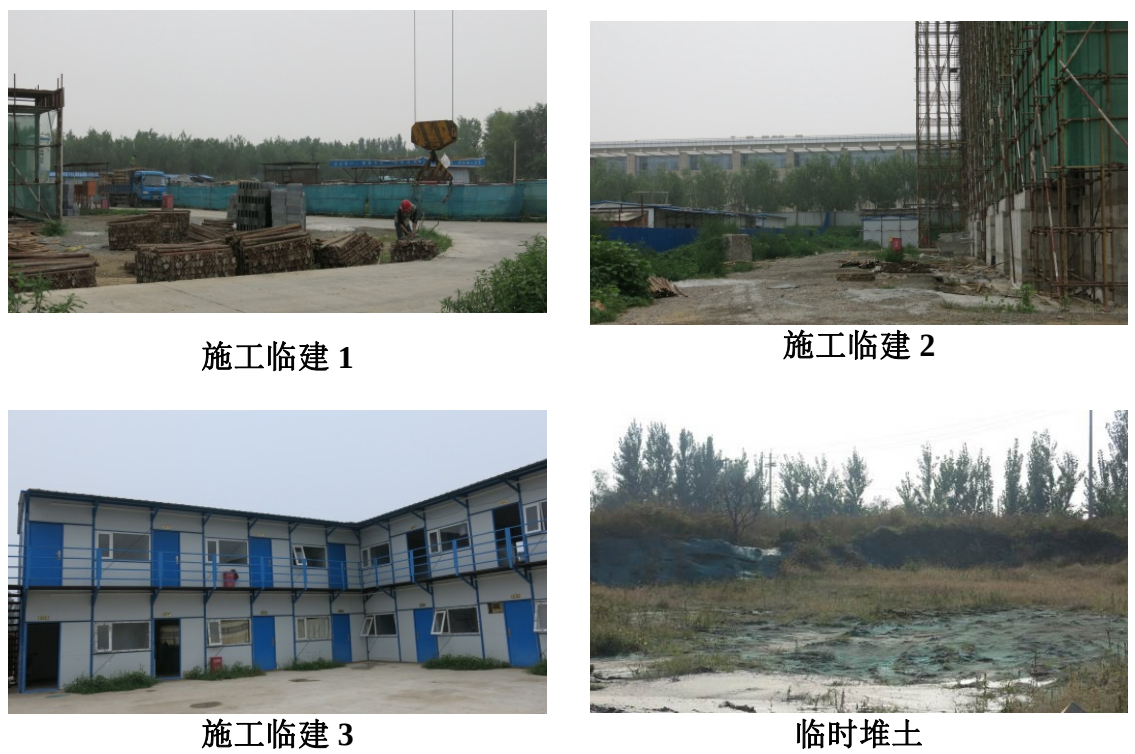
图 3-2 施工临建、临时堆土现场照片
